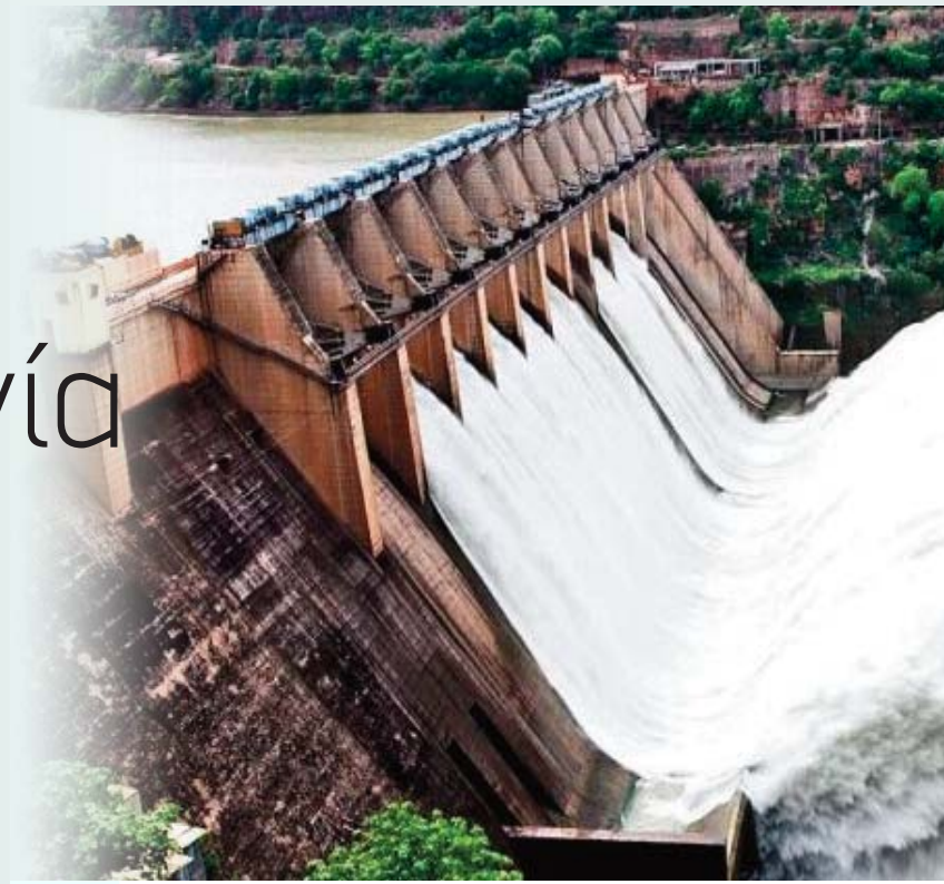
Στο τελικό στάδιο για να πέσουν οι υπογραφές εξαγοράς του υδροηλεκτρικού σταθμού Cebren
