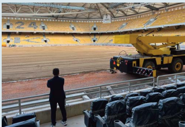
Στις εργασίες κατασκευής του «κιτρινόμαυρου» γηπέδου
