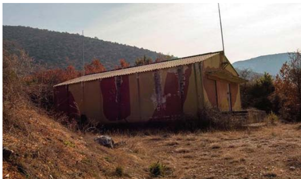
Οι αποθήκες Πυρομαχικών Αμπελοκήπων στην Ορεστιάδα
