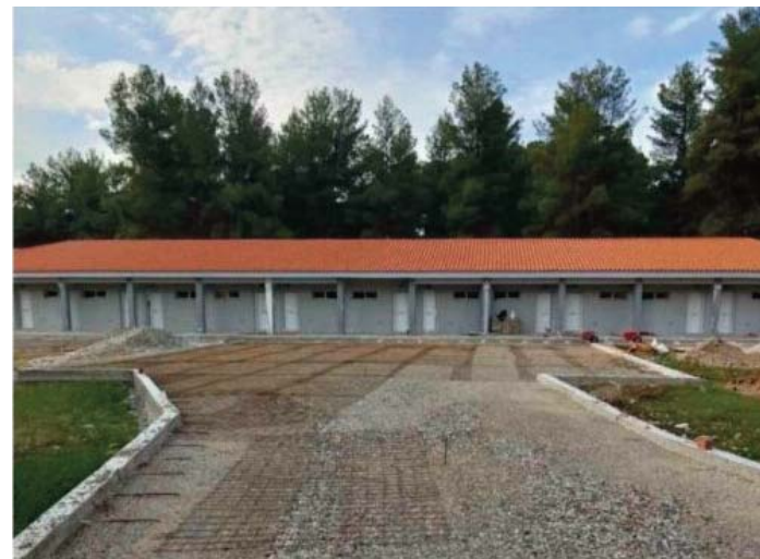
Σε τελικό στάδιο η ανακαίνιση του κτηρίου Μ-111 στην 114 Πτέρυγα Μάχης στην Τανάγρα
