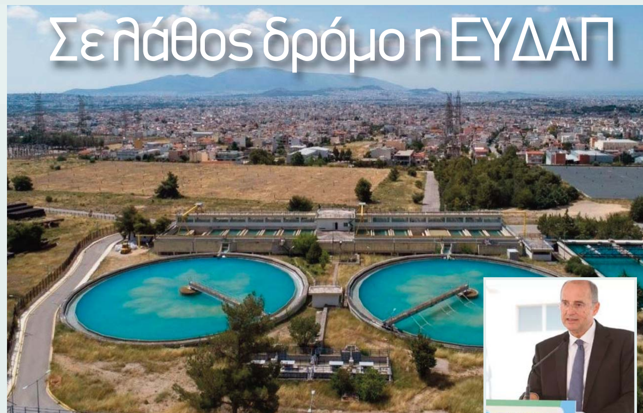
Τα περίεργα με τον διαγωνισμό για το Κέντρο Επεξεργασίας Λυμάτων των Δήμων Ραφήνας και Σπάτων και το βοθό τοπίο
