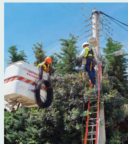
Τοποθέτηση εναέριας οπτικής ίνας
