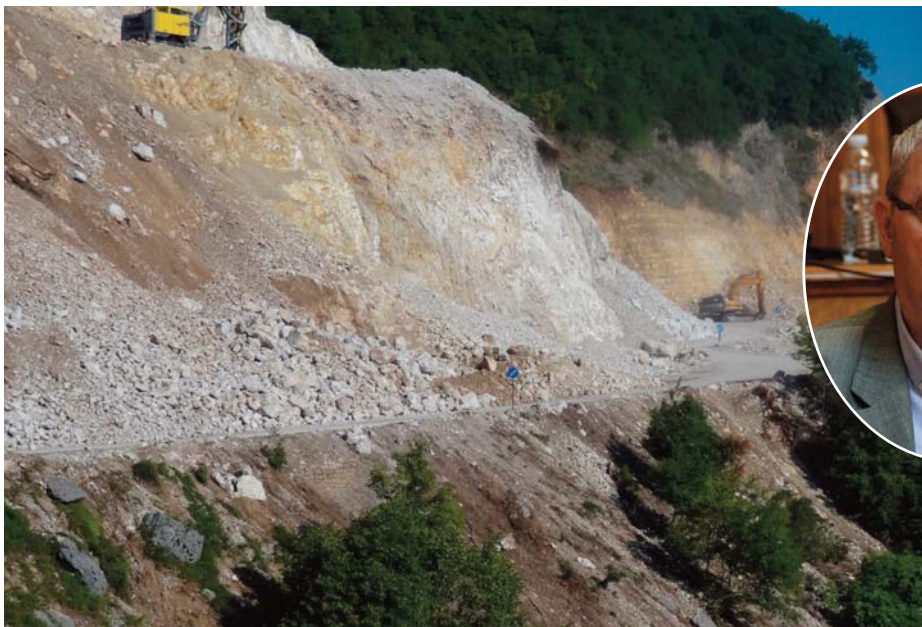
Τα αδρανή υλικά σωρεύονται στην άκρη του δρόμου, με αποτέλεσμα να καταρακουλών στα πρανή του Άραχθου και να συντελείται μεγάλη οικολογική καταστροφή
