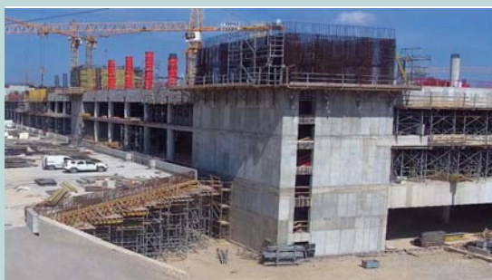
Το υπό κατασκευή αεροδρόμιο στο Καστέλι
