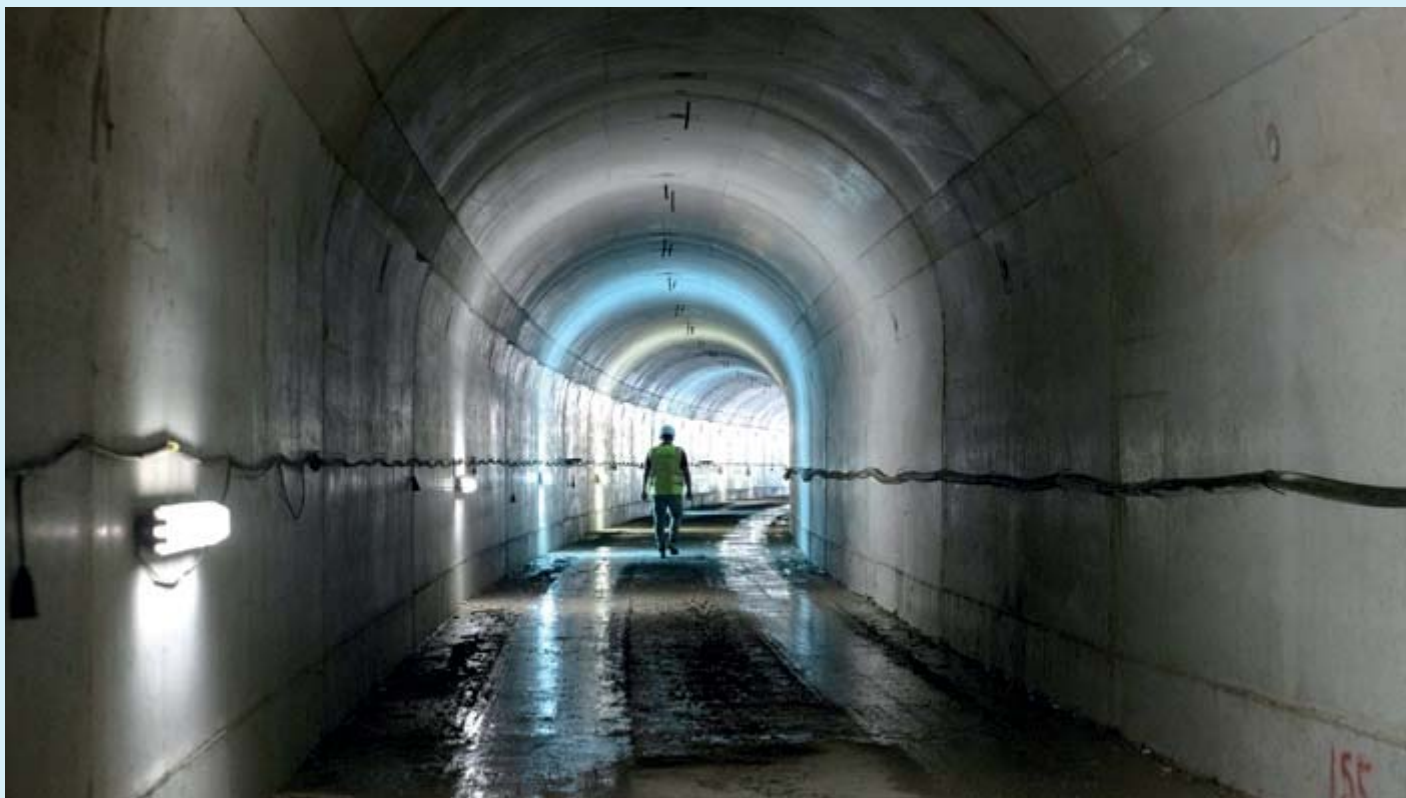
Σήραγγα διέλευσης αγωγών του Κέντρου Επεξεργασίας Λυμάτων Ραφήνας - Πικερμίου - Σπάτων - Αρτέμιδας, Πηγή: Αρχείο ΕΥΔΑΠ
