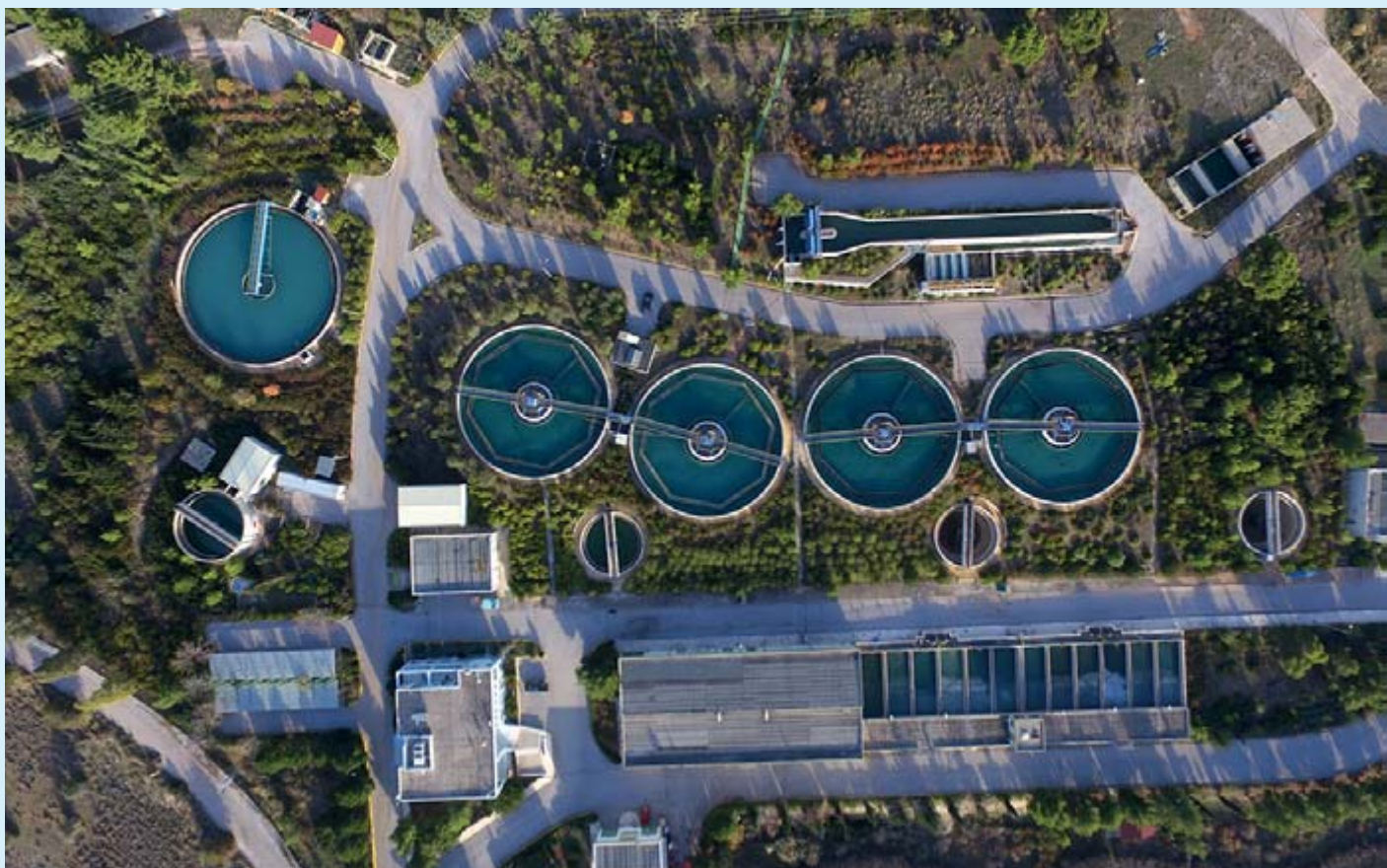
Μονάδα Επεξεργασίας Νερού Ασπροπύργου, Πηγή: Αρχείο ΕΥΔΑΠ
