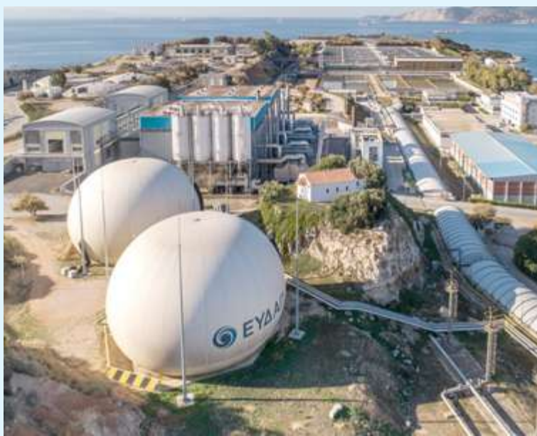
Κέντρο Επεξεργασίας Λυμάτων Ψυττάλειας, Πηγή: Αρχείο ΕΥΔΑΠ
