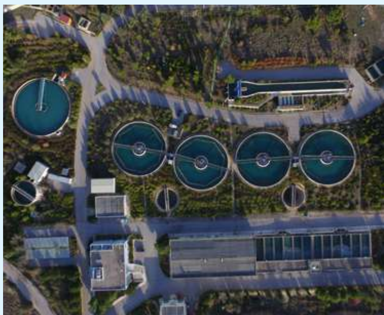
Μονάδα Επεξεργασίας Νερού Ασπροπύργου, Πηγή: Αρχείο ΕΥΔΑΠ
