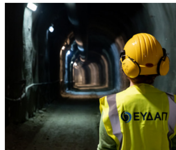
Εργασίες Κατασκευής Σήραγγας του Κέντρου Επεξεργασίας Λυμάτων Ραφήνας - Πικερμίου - Σπάτων - Αρτέμιδας, Πηγή: Αρχείο ΕΥΔΑΠ
