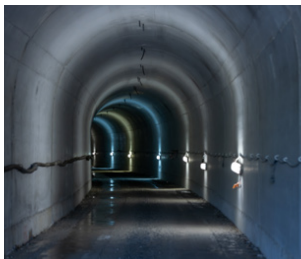
Σήραγγα διέλευσης αγωγών του Κέντρου Επεξεργασίας Λυμάτων Ραφήνας - Πικερμίου - Σπάτων - Αρτέμιδας, Πηγή: Αρχείο ΕΥΔΑΠ
