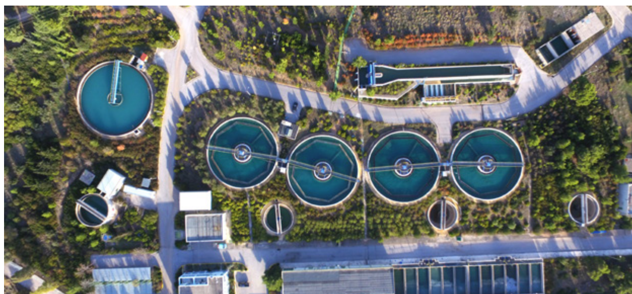
Μονάδα Επεξεργασίας Νερού Ασπροπύργου, Πηγή: Αρχείο ΕΥΔΑΠ
