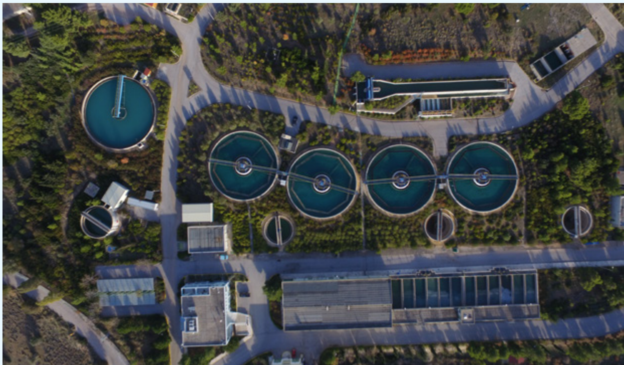
Μονάδα Επεξεργασίας Νερού Ασπροπύργου, Πηγή: Αρχείο ΕΥΔΑΠ
