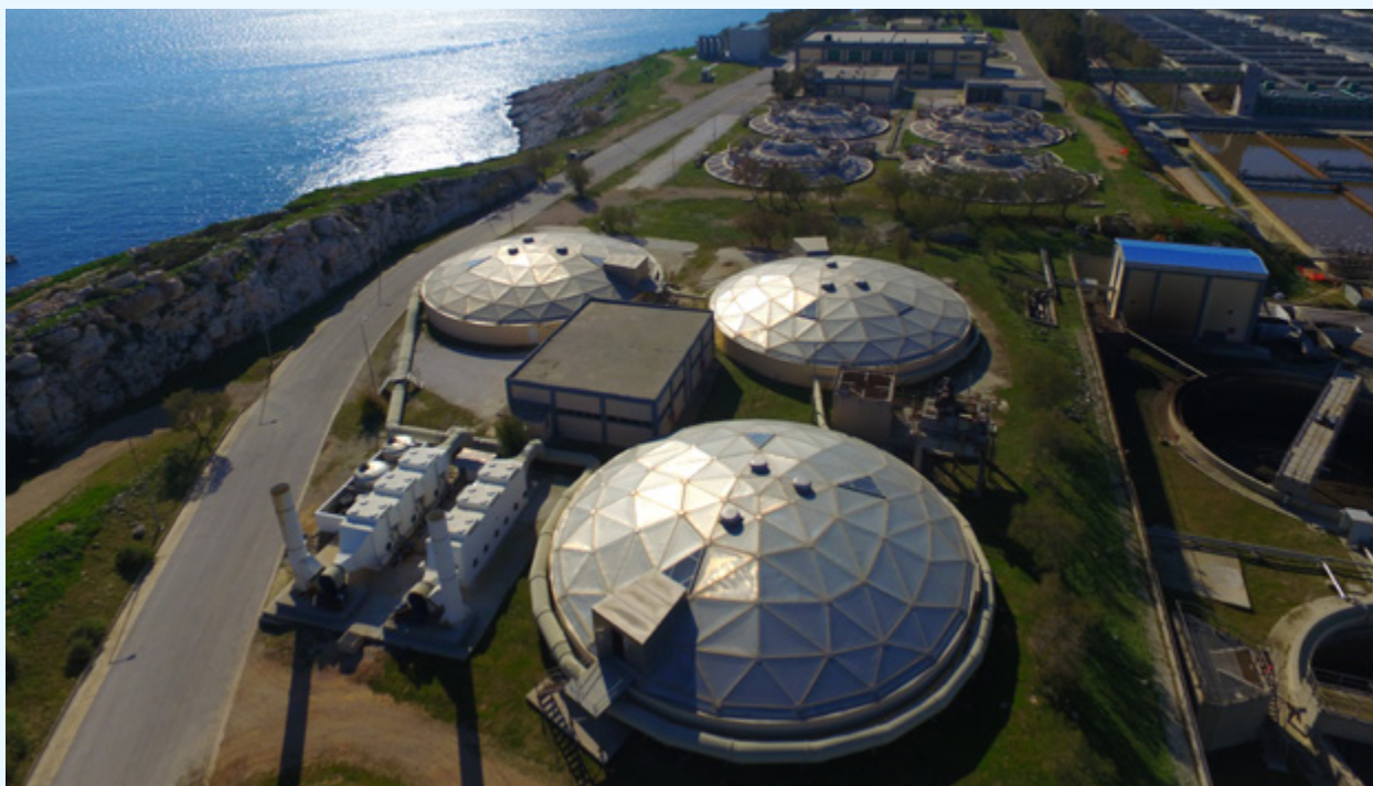
Κέντρο Επεξεργασίας Λυμάτων Ψυττάλειας, Πηγή: Αρχείο ΕΥΔΑΠ
