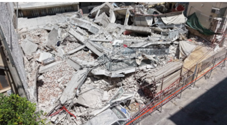
Οι πρώτες εκτιμήσεις δείχνουν πως το κτίριο έπεσε επειδή δεν τηρήθηκαν τα απαιτούμενα μέτρα αντιστήριξης κατά τη διάρκεια των εργασιών στο διπλανό στο εργοτάξιο
