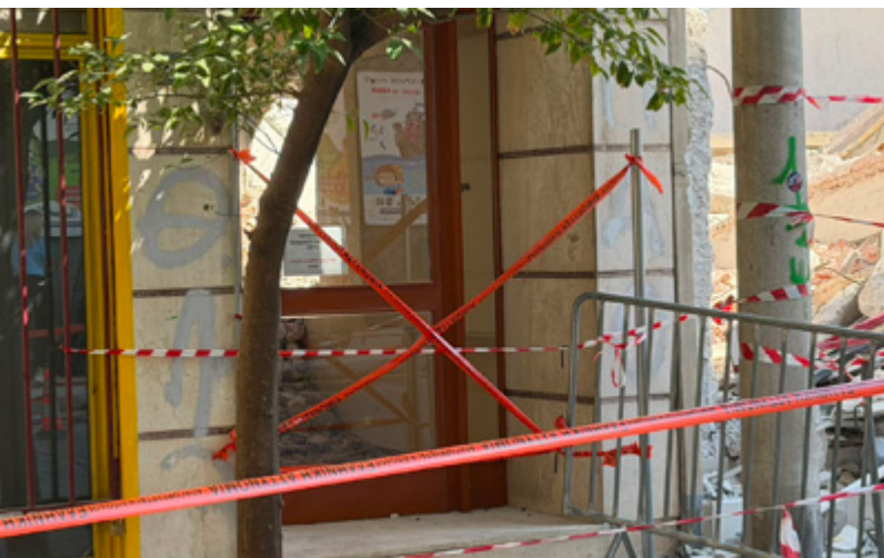
Η πολυκατοικία που εφάπτεται ακριβώς με το κτίριο που έπεσε σφραγίστηκε μέχρι να γίνουν οι απαραίτητοι έλεγχοι
