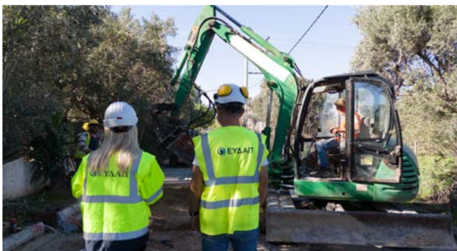
Εργασίες Κατασκευής Δικτύου Αποχέτευσης Δήμου Σπάτων - Αρτέμιδος, Πηγή: Αρχείο ΕΥΔΑΠ
