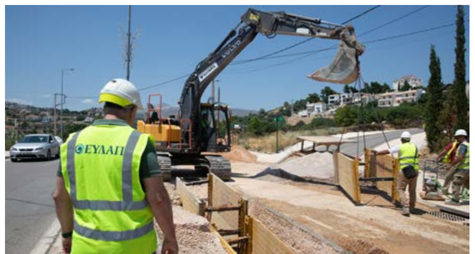
Εργασίες Κατασκευής Δευτερεύοντος Δικτύου Δήμου Παλλήνης, Πηγή: Αρχείο ΕΥΔΑΠ
